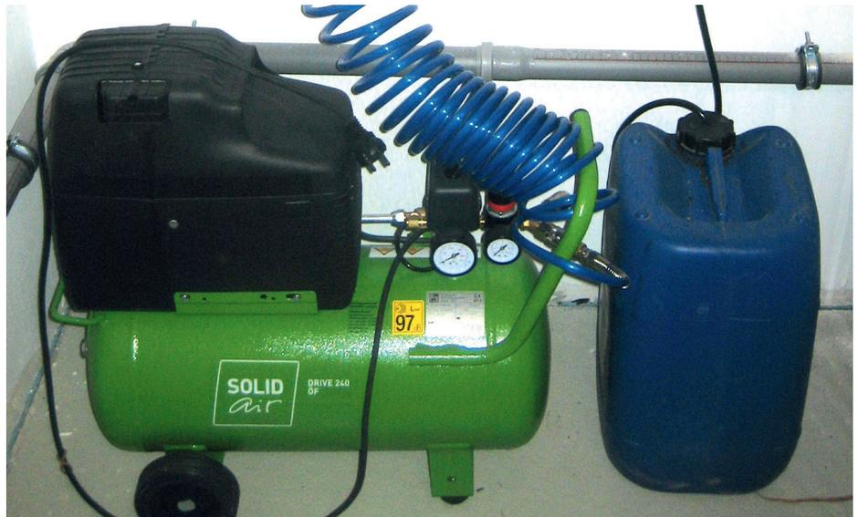
Dazu gehört auch ein Kompressor, mit dem bei Frostgefahr die Leitungen der Bewässerungsanlage automatisch von Wasser freigeblasen werden, rechts daneben der Behälter für die Düngeflüssigkeit.
